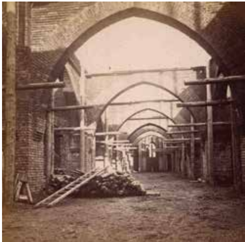
Die Bauarbeiten lassen Ende des Jahres 1881 bereits den Rohbau der Unterkirche erkennen.
